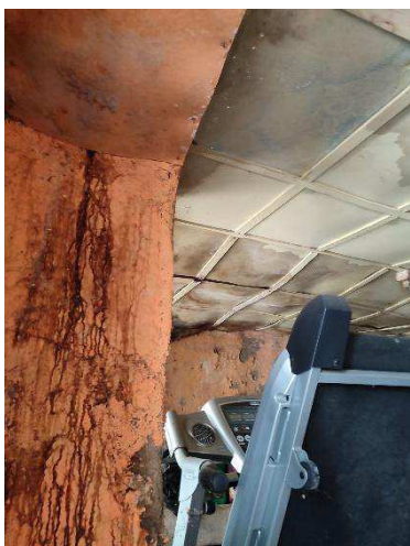
10. Interior do prédio urbano
