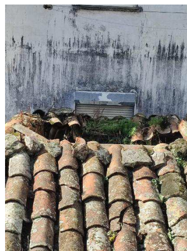
6. Pormenor da Cobertura
