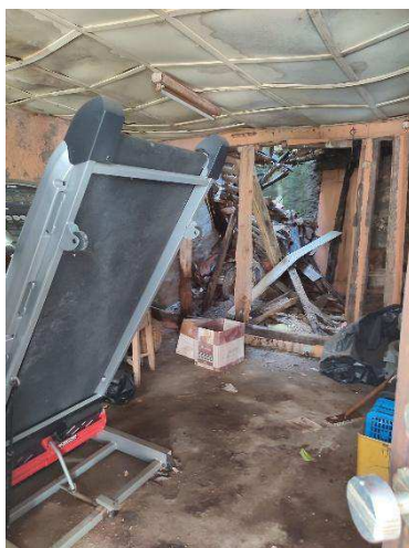
11. Interior do prédio urbano
